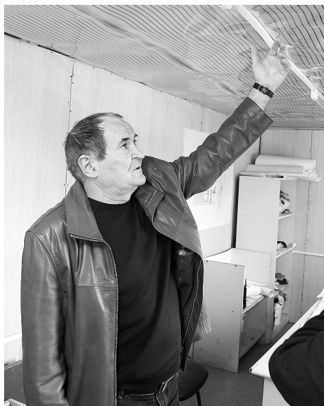
2004 год: установленный экспериментальный образец системы отопления ПЛЭН. Отработал без замечаний десять лет. 2014 год: современное серийное изделие ПЛЭН. Имеет класс защиты IP67. Фото Александра ФИРСОВА
