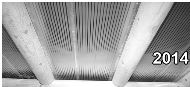
2004 год: установленный экспериментальный образец системы отопления ПЛЭН. Отработал без замечаний десять лет. 2014 год: современное серийное изделие ПЛЭН. Имеет класс защиты IP67. Фото Александра ФИРСОВА
